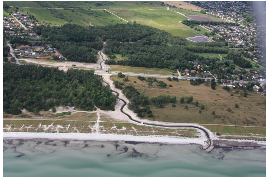
Klimasikring Karlstrup Mose
