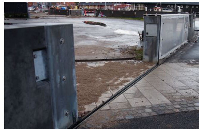
Højvandsmur med mobilt skot - her "Le Mur" i Lemvig
