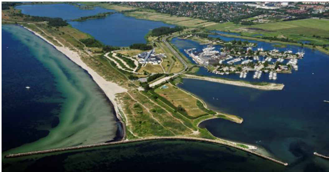
Køge Bugt Strandpark - Strandparken har en indbygget højvandsikring fra Hundige Centervej i vest til Avedøre Holme i øst, som man ikke bemærker i de daglige rekreative brug af området.
